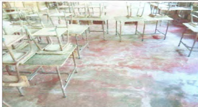
El piso es entortada de cemento
